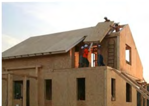
Рис.2-6. Технологическая последовательность возведения здания из композитных панелей РаПан
