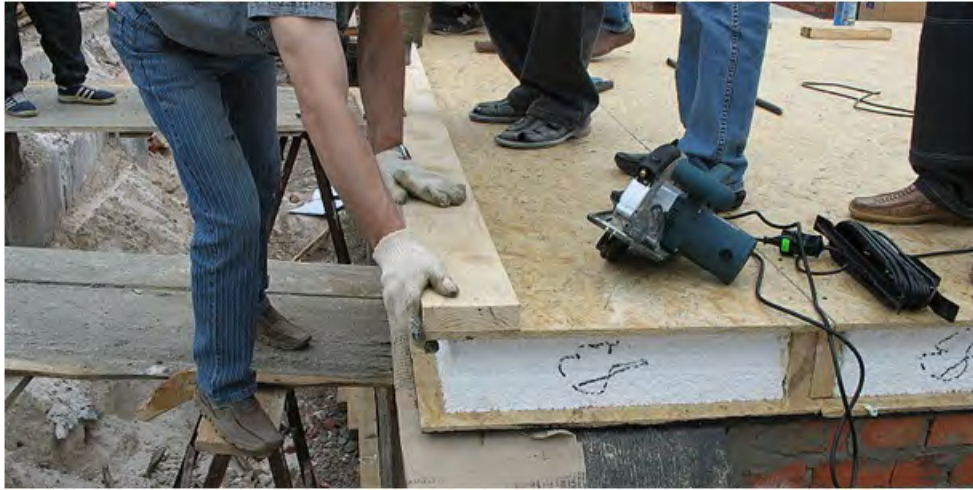
Рис.14. Укладка доски обвязки строго вдоль кромки ОСП, заподлицо
