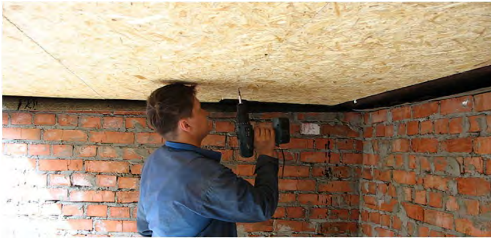
Рис.12. Фиксация панелей саморезами снизу
