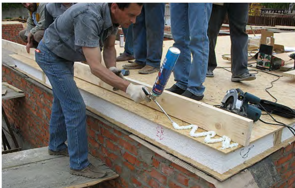
Рис.13. Укладка доски обвязки и нанесение небольшого количества пены
