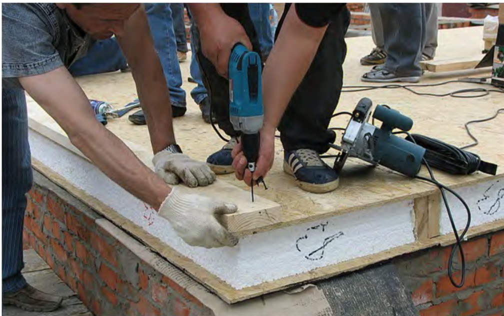
Рис.15. Саморезы вкручиваются "змейкой" через 15-20 см
