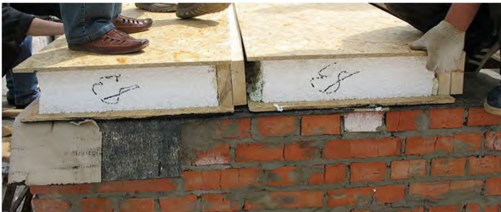
Рис.10. Соединение панелей через соединительную шпонку
