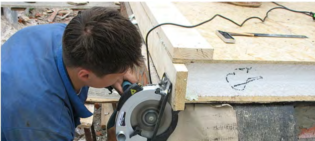
Рис. 19. Спиливание доски заподлицо
