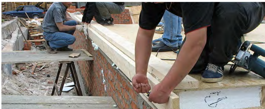
Рис.17. Установка торцевой доски обвязки
