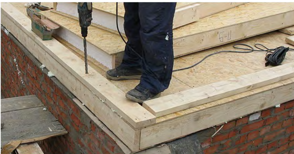
Рис.23. Крепление "палубы" к фундаменту
