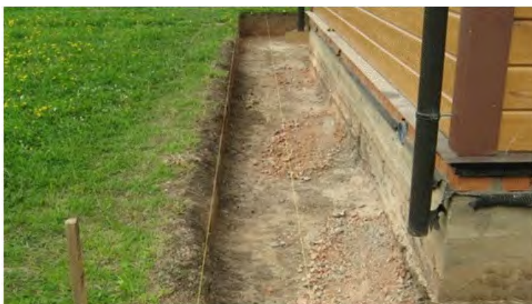
Рис.4. Разметка отмостки - важный момент: без него невозможно выполнить работу качественно
