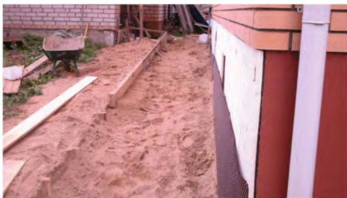
Рис.3. Подготовка траншеи для будущей отмостки
