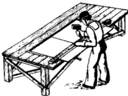
Рис.20. Изготовление картины рядового покрытия
