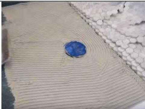
Рис.12. Укладка кассет в виде мелкой мозаики на специальный раствор
