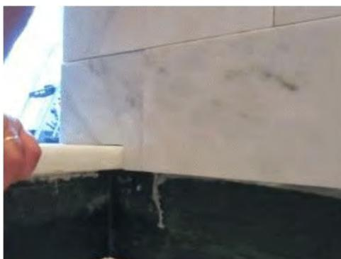
Рис.8. Подрезка мрамора
