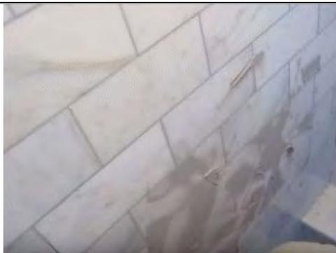
Рис.15. Швы заполняются раствором под цвет плитки
