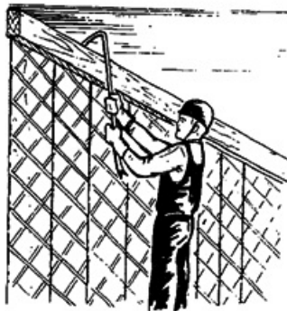
Рис.11. Отрыв брусков обвязки
