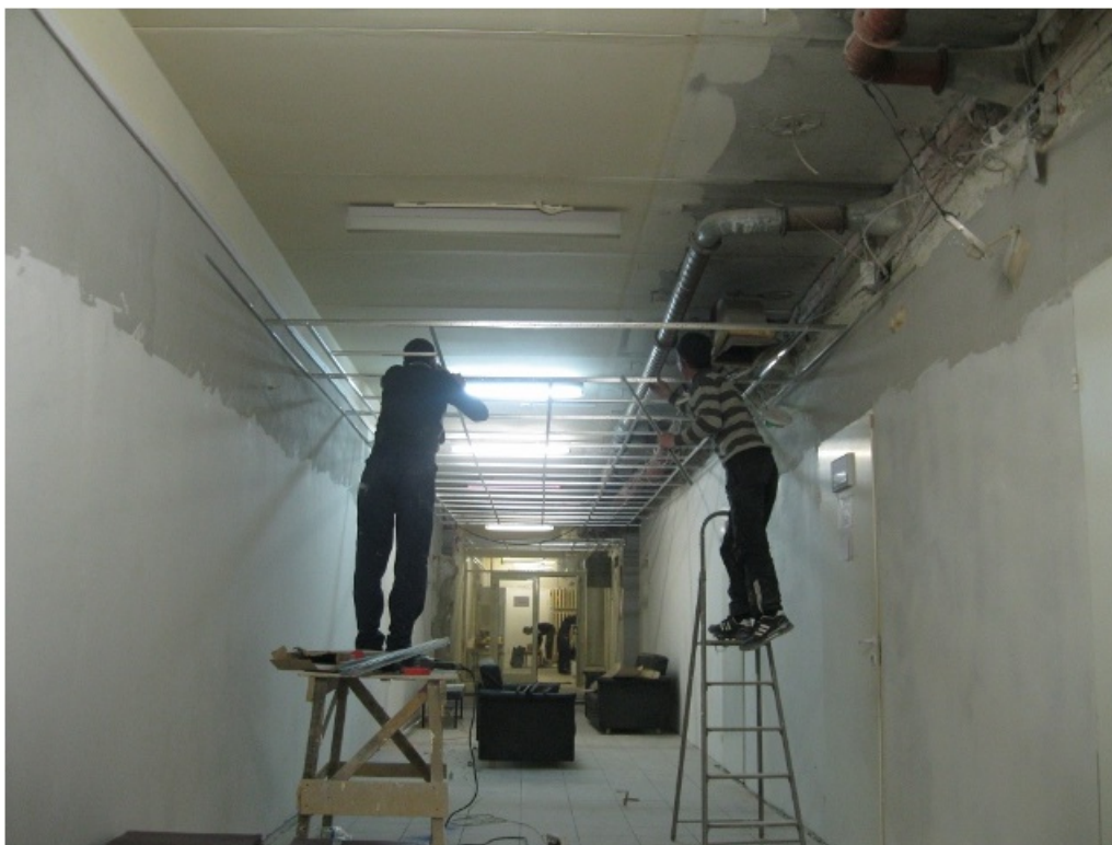
Рис.2. Установка направляющих реек
