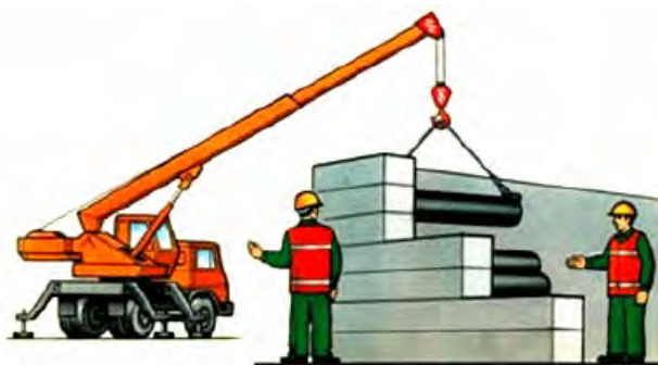
Рис.59. Передача сигналов в ограниченной зоне видимости
