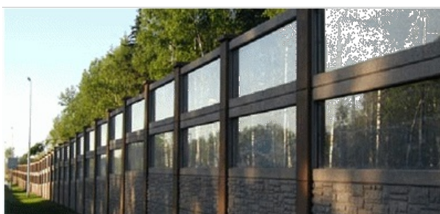
Рис.2. Экран из сплошных панелей (шумоотражающих или шумопоглощающих) со вставкой из стекла
