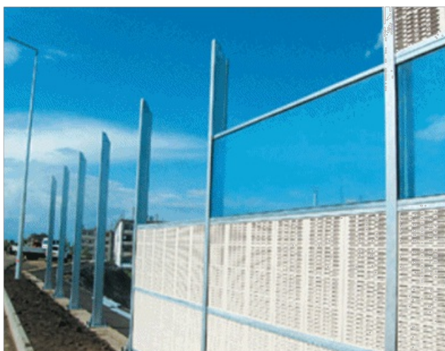
Рис.9-10. Монтаж шумопоглощающих панелей
