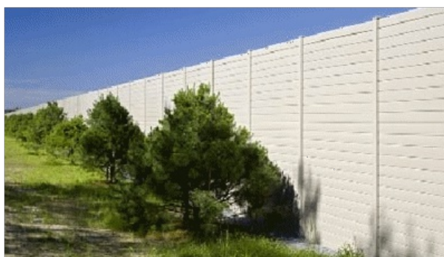
Рис.1. Экран из сплошных панелей (шумоотражающих или шумопоглощающих)
