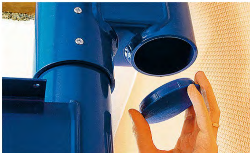
Рис.16. На все открытые металлические части устанавливаются пластиковые заглушки
