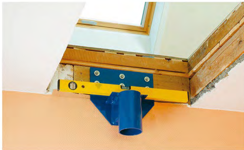
Рис.8. Прикрепление первого опорного элемента, используя строительный уровень
