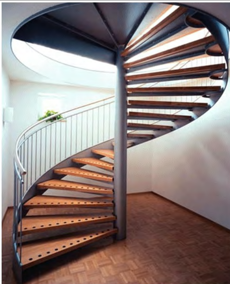
Рис.4. Пример комбинированной лестницы из дерева и металла
