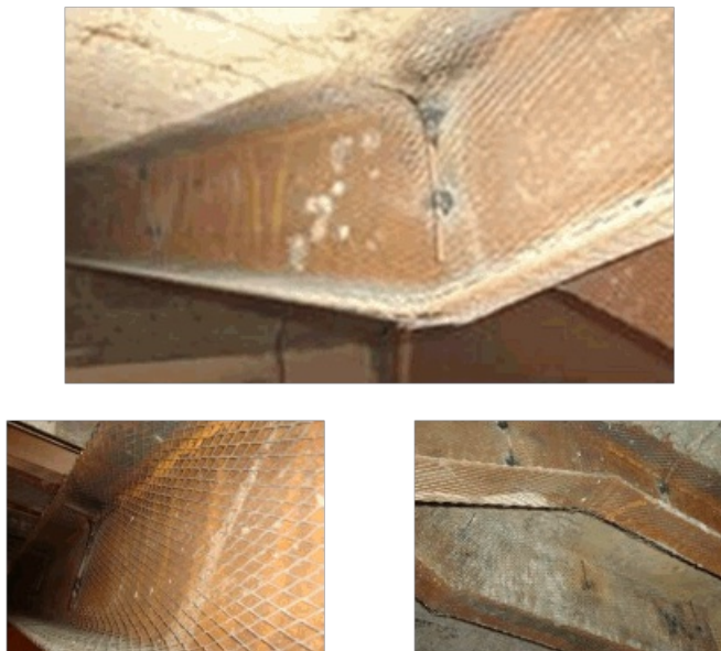
Рис.4-6. Крепится сетка непосредственно к швеллеру
