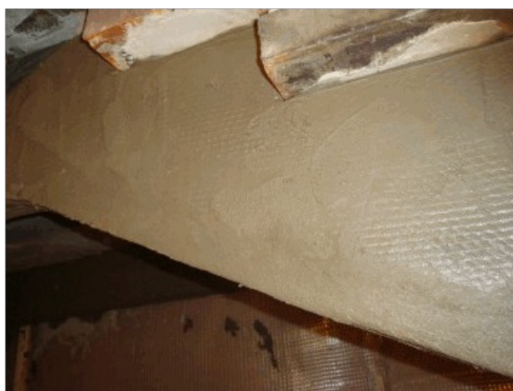
Рис.8. Заштукатуривается вся поверхность металла
