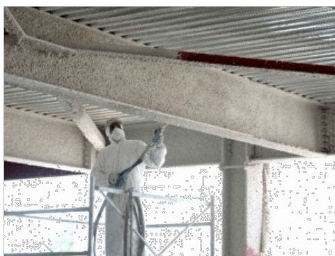
Рис.3. Нанесение раствора методом распыления
