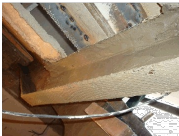
Рис.7. Наносится поверх сетки штукатурная смесь
