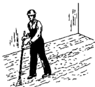
Рис.14. Очистка поверхности плиты от грязи
