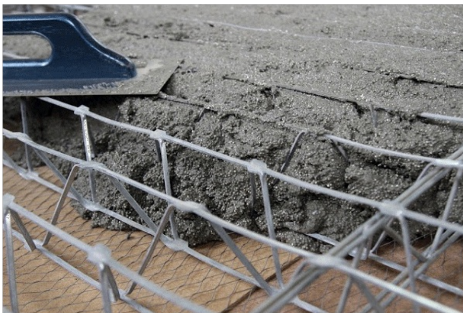
Рис. 18. Укладка жесткой бетонной смеси в опалубку
