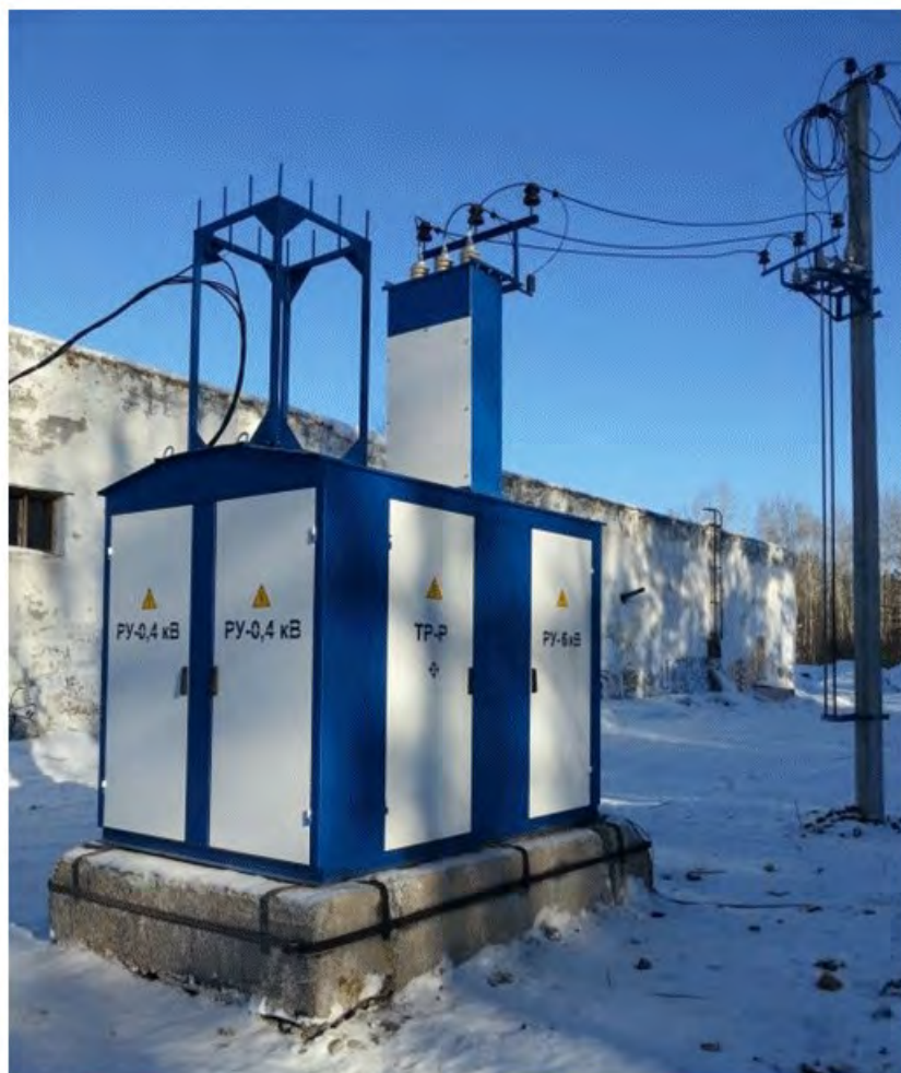
Рис.25. Смонтированная КТПн
