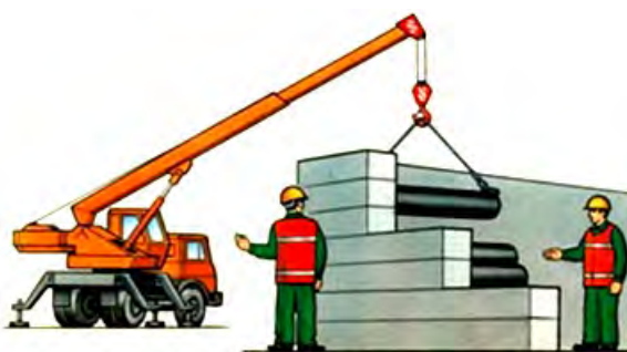
Рис.18. Передача сигналов в ограниченной зоне видимости
