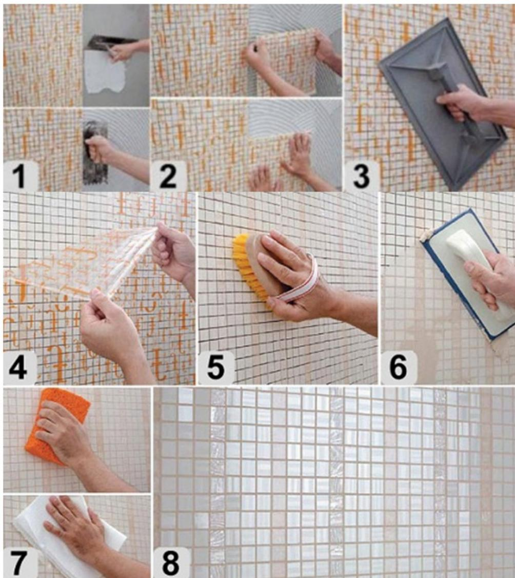
Рис.17. Последовательность (поз.1-8) монтажа сетчатой мозаики
