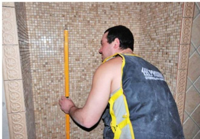
Рис.11. Проверка плоскостности
