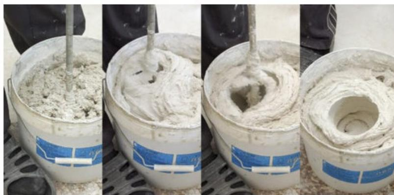
Рис.7. Замес небольшого количества клеевой смеси
