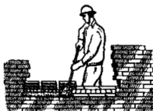
Рис.18. Расстилание раствора для тычкового ряда наружной версты
