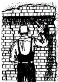
Рис.14. Смачивание пробитой борозды
