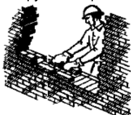
Рис.24. Раскладка кирпича для тычкового ряда внутренней версты
