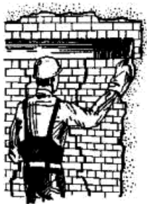
Рис. 15. Зачеканка зазоров между балкой и старой кладкой
