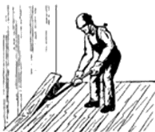
Рис.23. Отрыв крайней доски
