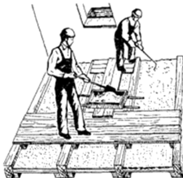
Рис.12. Разборка засыпки
