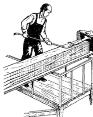
Рис.16. Освобождение балки от анкера
