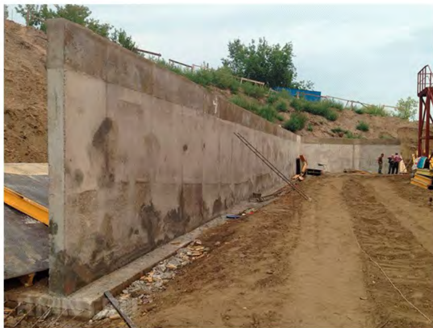
Рис.11. Снятие опалубки возможно только при наборе бетоном 100%
