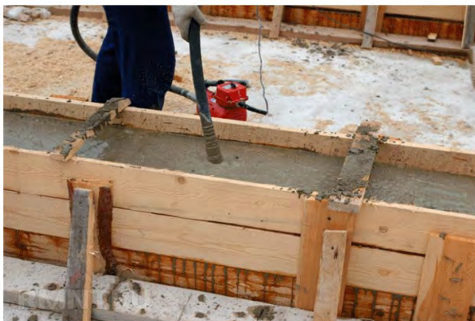
Рис.10. Уплотнение бетонной смеси
