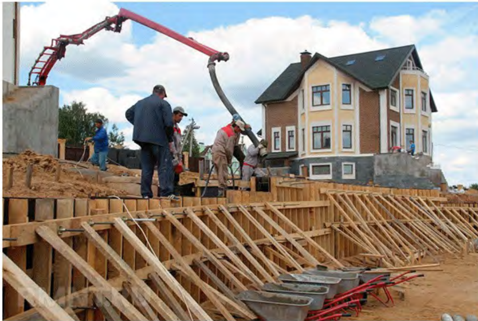
Рис.9. Укладка бетона
