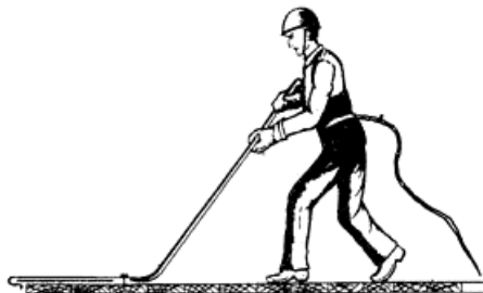
Рис.13. Снятие карнизного свеса
