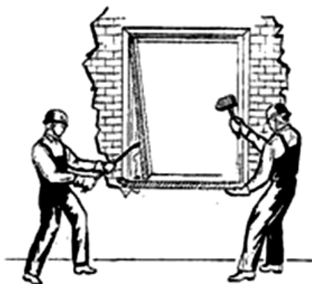
Рис.20. Снятие оконной коробки
