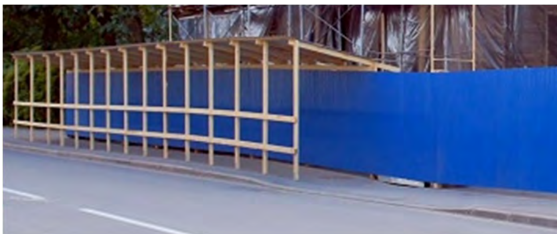
Рис.8. Схема сборки закрытой пешеходной галереи
