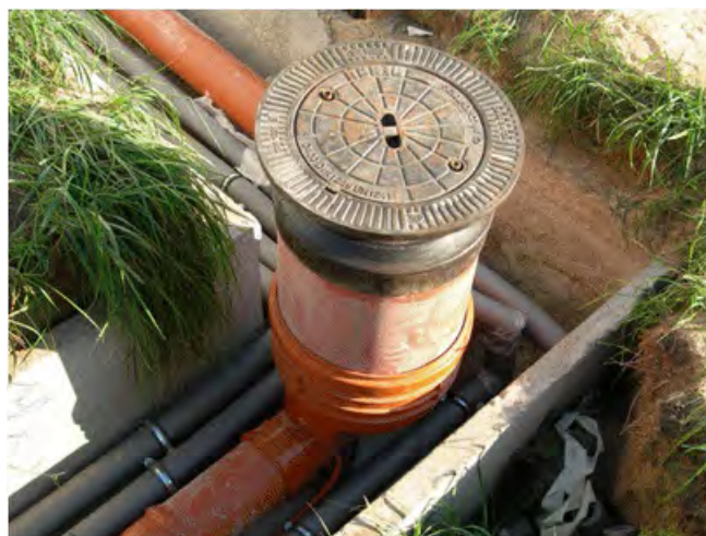
Рис.5. Металлический люк, которым заканчивается рабочая камера
