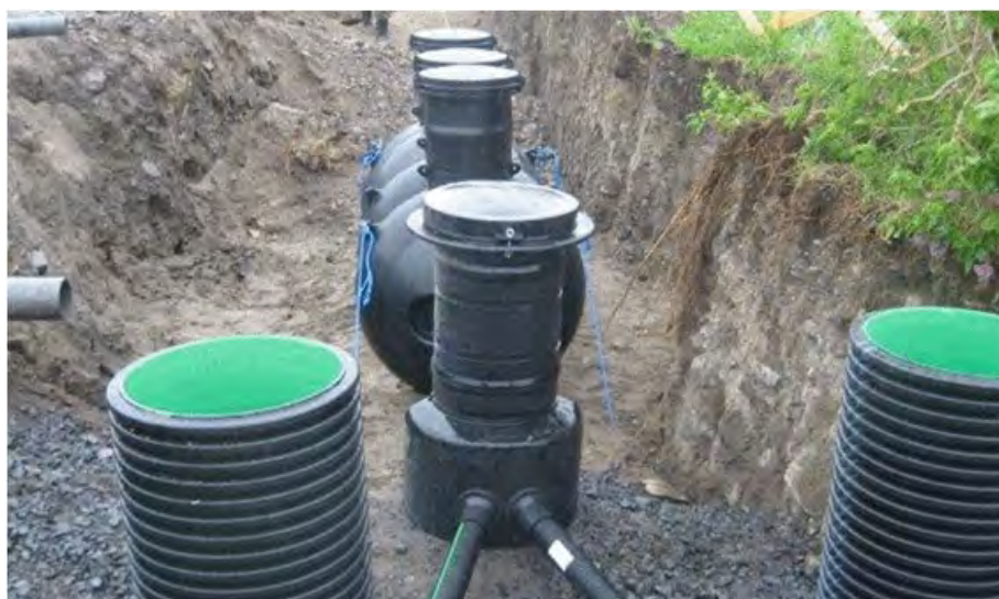
Рис.9. Подключение труб
