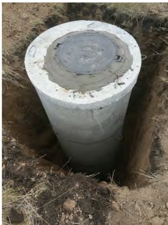
Рис.3. Заделка мест стыков и зазоров
