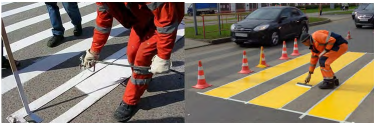
Рис.10. Нанесение маркировочных материалов вручную
