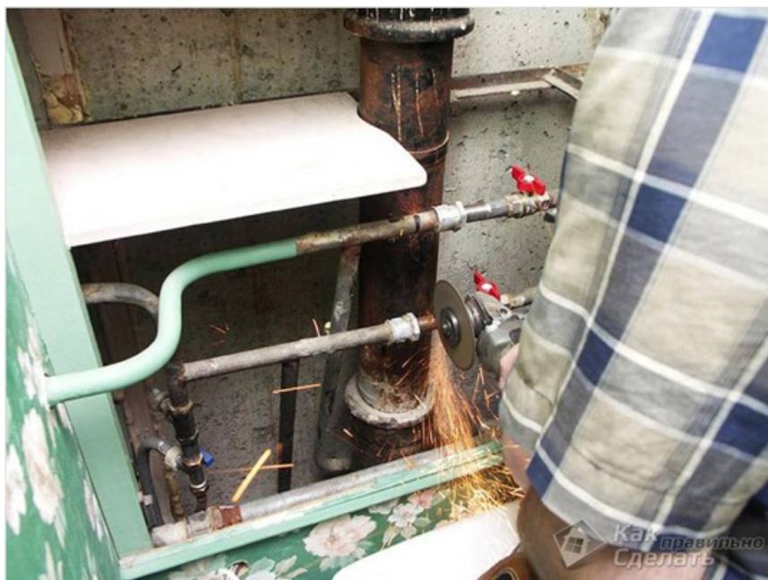
Рис.5. Выпиливание фрагмента трубы
