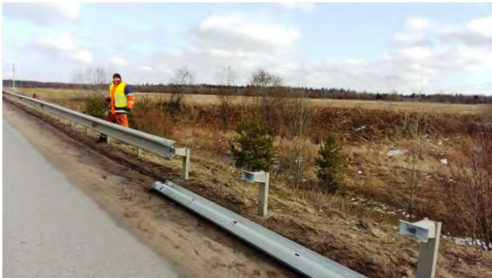
Рис.22. Монтаж секций балок СБ-1 рабочего участка
