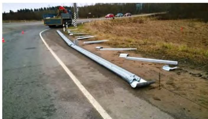
Рис.9. Развозка и раскладка секций балок на обочине
