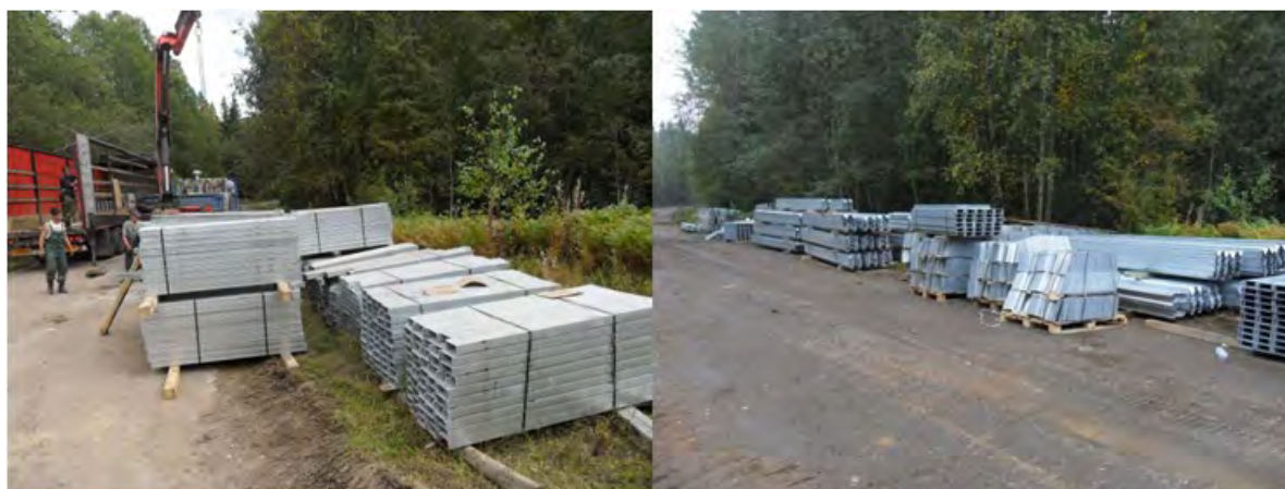
Рис.8. Складирование элементов ограждения на объекте
