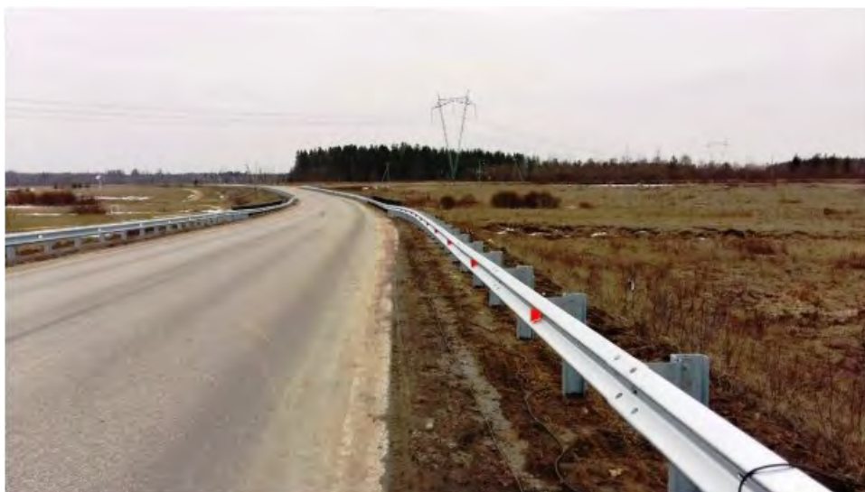
Рис.24. Готовый участок дорожного барьерного ограждения 11ДО-2
