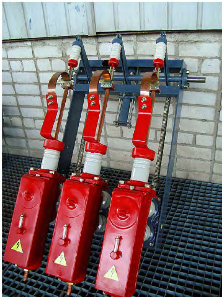
Рис.2. Масляный выключатель типа ВМГ-133
