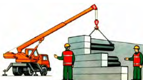
Рис.20. Передача сигналов в ограниченной зоне видимости
