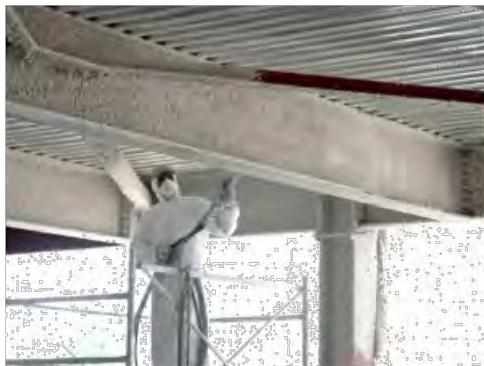
Рис.3. Нанесение раствора методом распыления
