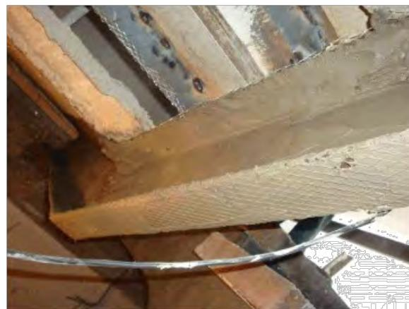
Рис.7. Наносится поверх сетки штукатурная смесь
