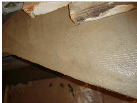
Рис.8. Заштукатуривается вся поверхность металла
