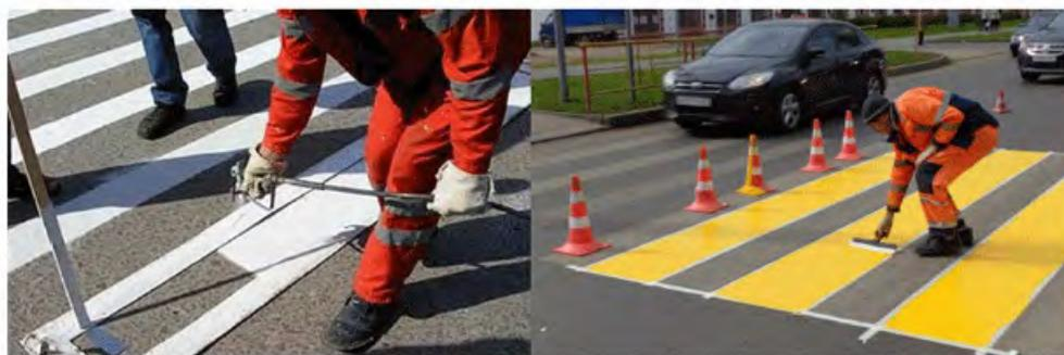
Рис. 13. Нанесение маркировочных материалов вручную
