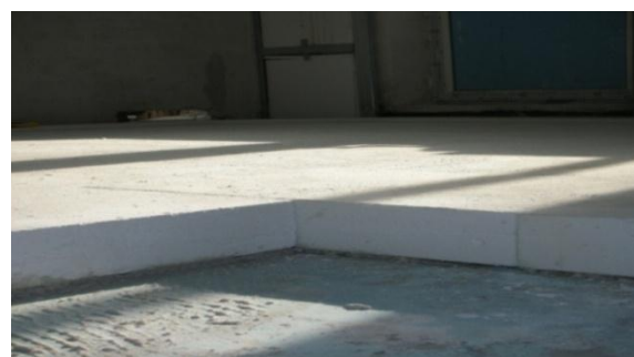
Утепление пола первого этажа
