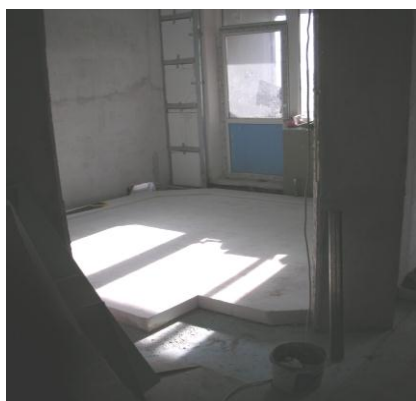
Утепление пола первого этажа
