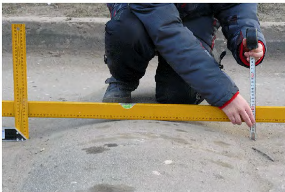
Рис.16. Контроль высоты монолитной конструкции ДИН
