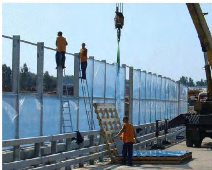
Рис.28. Установка однослойных светопрозрачных акустических панелей
