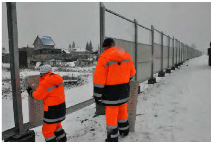
Рис.27. Установка многослойных акустических панелей на опорный профиль
